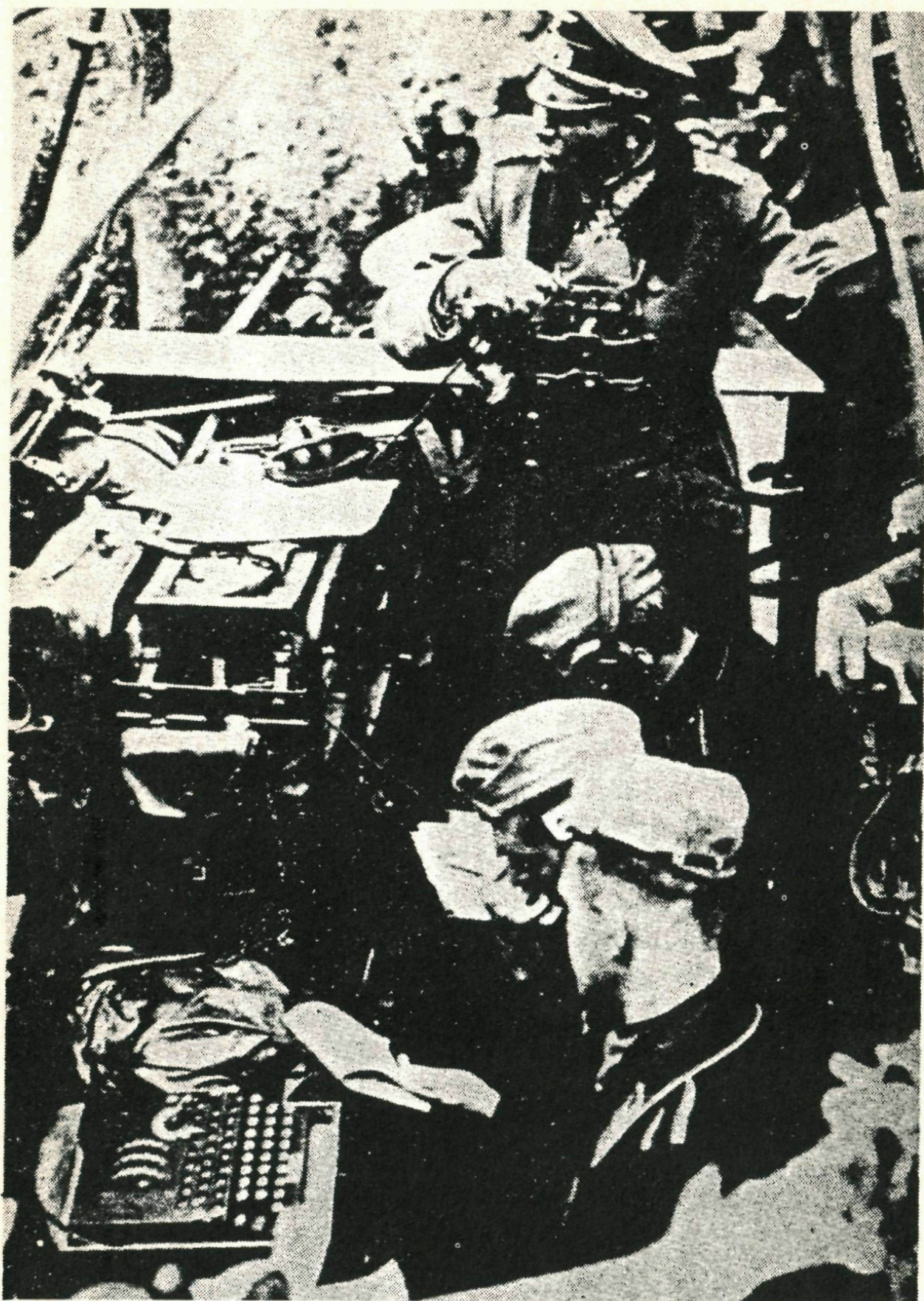
Figuur 4. De praktijk. Een kijkje in een commandowagen van het Duitse leger. Vooraan de Enigma, daar achter de zend-installatie. Let op de papieren die de bedieners van Enigma en zend-installatie in hun handen hebben.
